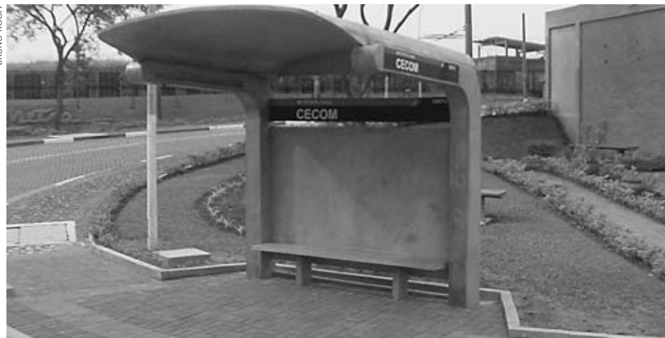
Estações são construídas em concreto, o que garante a sua durabilidade
